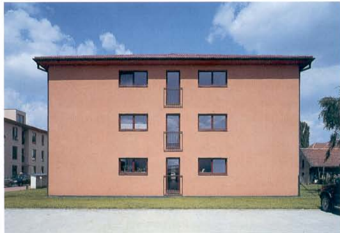
jižní fasáda domu D
